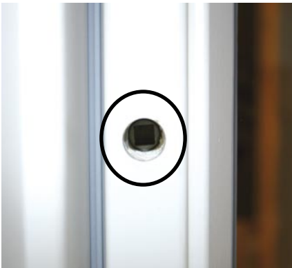
Abbildung 7: Sicherungsschraube wird montiert
